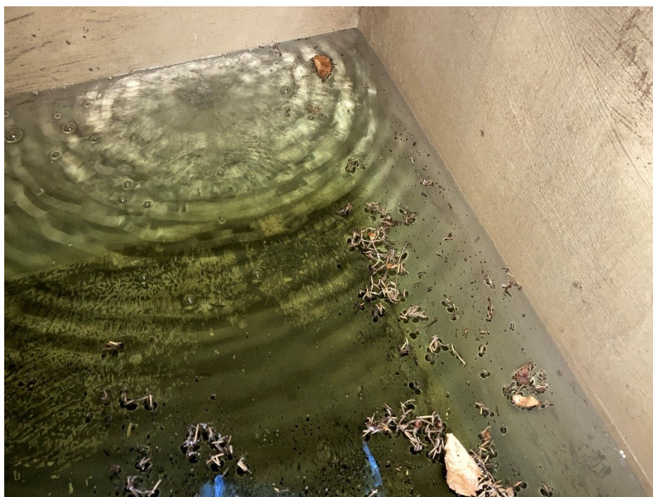
Figura 5. Interno di una delle opere di presa. Sedimenti e surnatanti possono inficiare la qualità delle acque.
