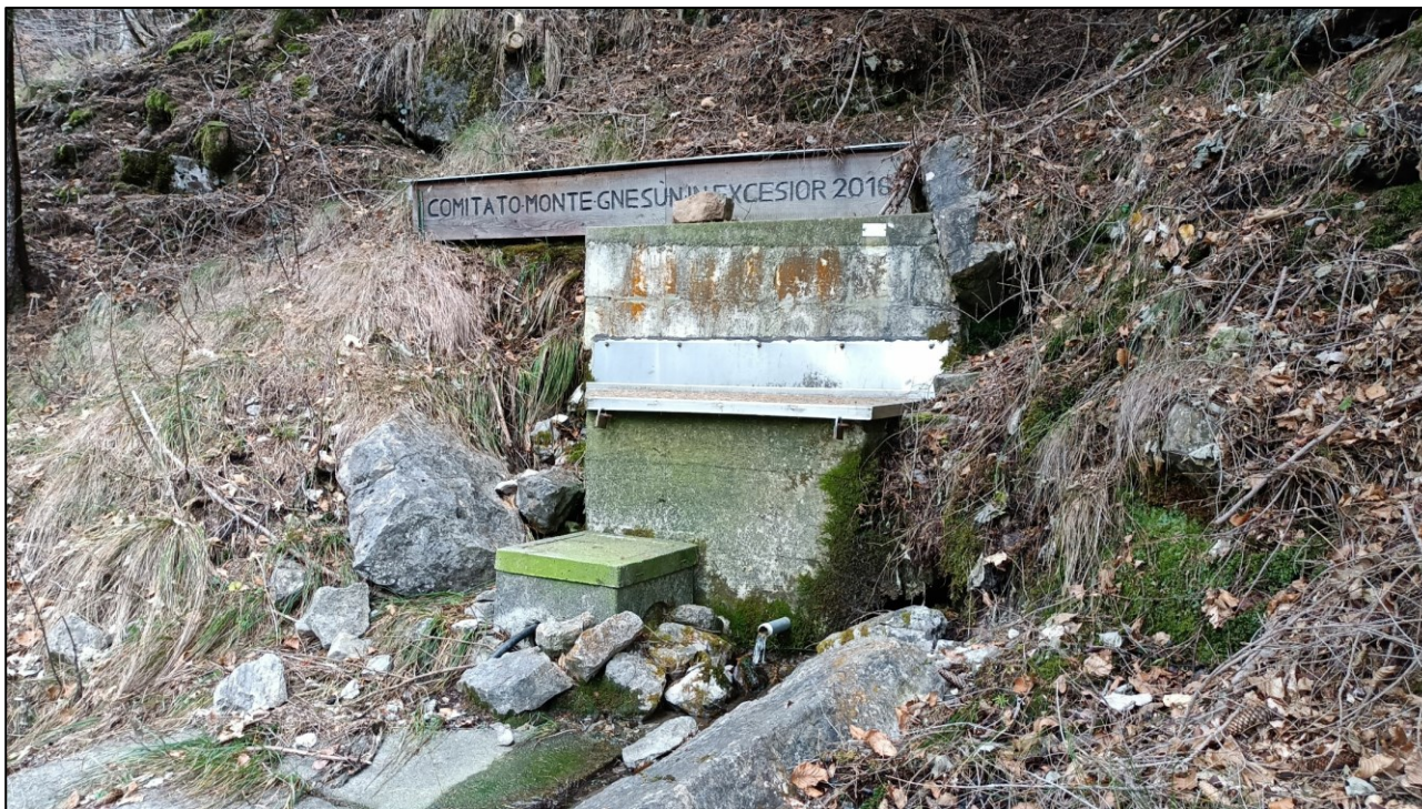
Figura 10. Opera di presa sorgenti "Acqua del Pocc"
